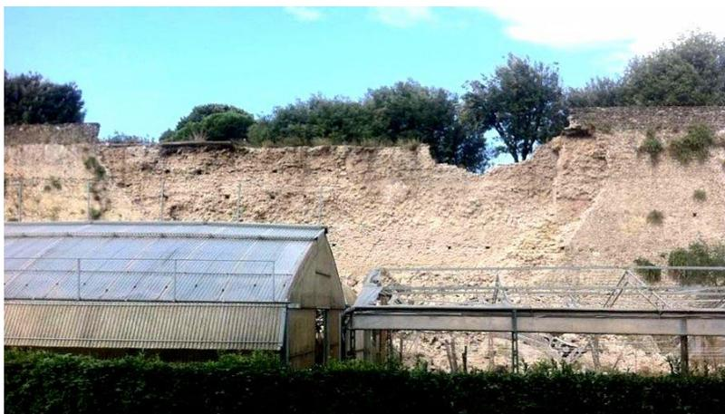
**Figura 37.** Il crollo delle mura urbane di Pistoia visto dalla parte esterna alla città lungo il torrente Brana (Settembre 2011).
