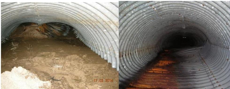
**Figura 4.** Collasso di Monte Pinu e condizioni dei tubolari (da Giresini et al, 2016).
