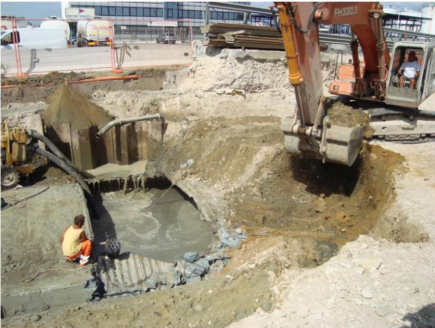
**Figura 3.** Collasso del tubolare metallico in Darsena Toscana FI-PI-LI (da Gioeli, 2009).
